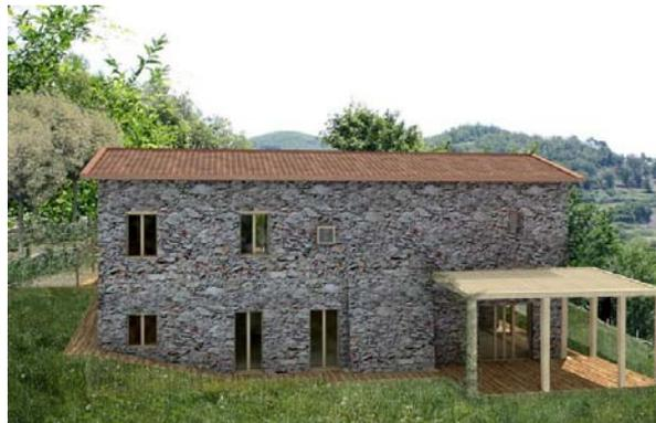
Le facciate esistenti manterranno l'aspetto originale, con adeguamenti minori delle aperture, manutenzione della finitura in pietra esistente e rifacendo gli intonaci a calce colorati in "rosso malaspina" per mantenere leggibile la differenza tra i due corpi di fabbrica edificati in secoli diversi.
