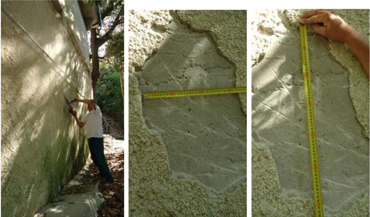
*Rimozione intonaco parete esterna al piano seminterrato (prospetto sud)*
