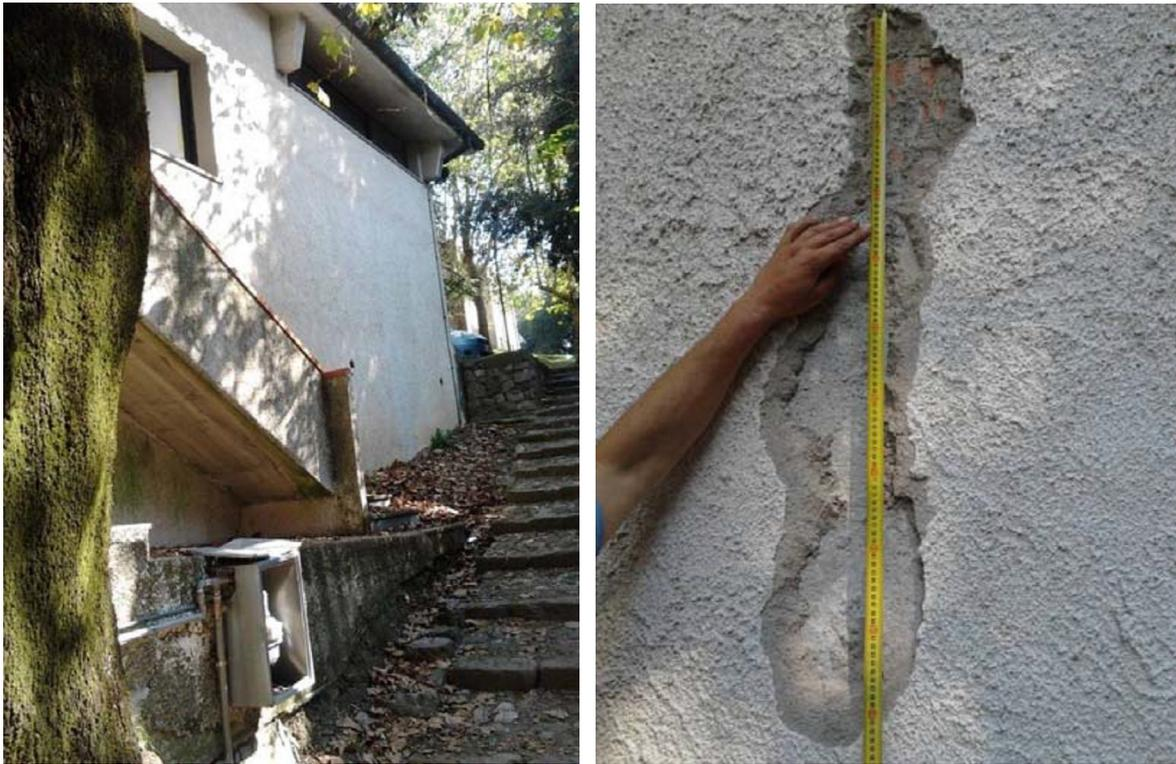
*Rimozione intonaco in corrispondenza del muro contro terra esterno a sud*
