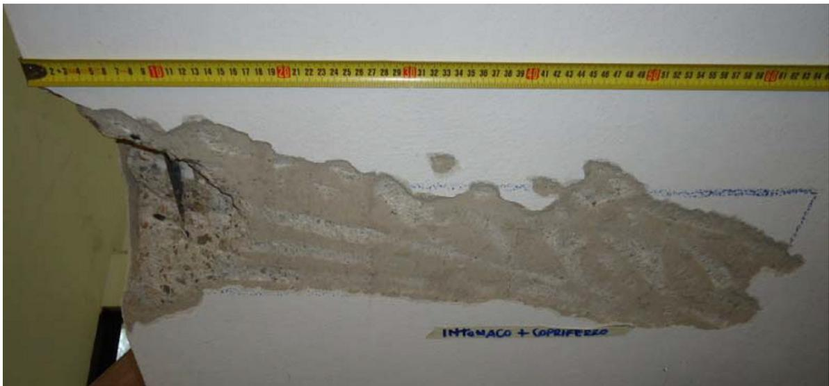
*Rimozione intonaco e copri ferro in corrispondenza della soletta della scala*
