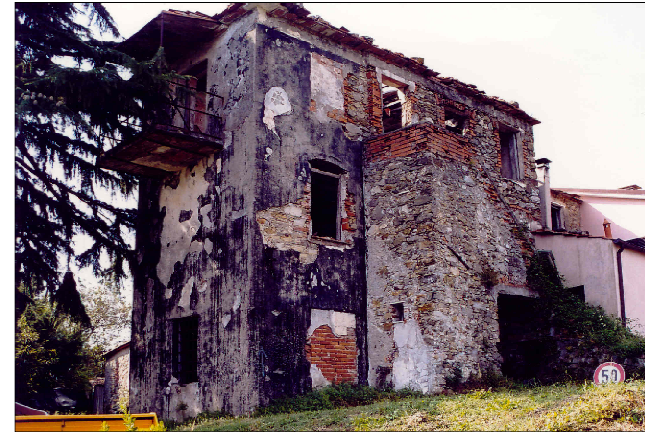
Vista n.3 Vista da Sud-Est.
