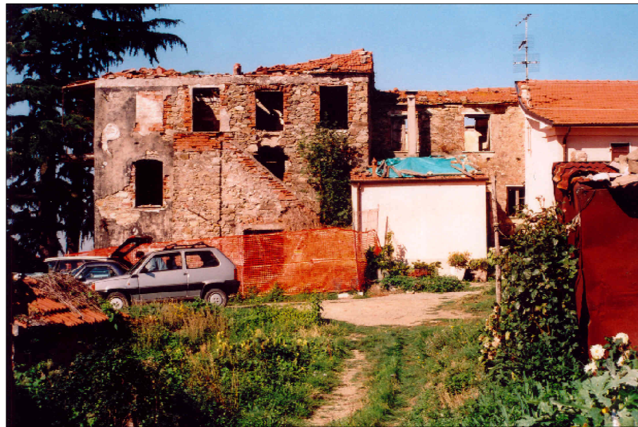
Vista n. 2 Prospetto lato Est.
