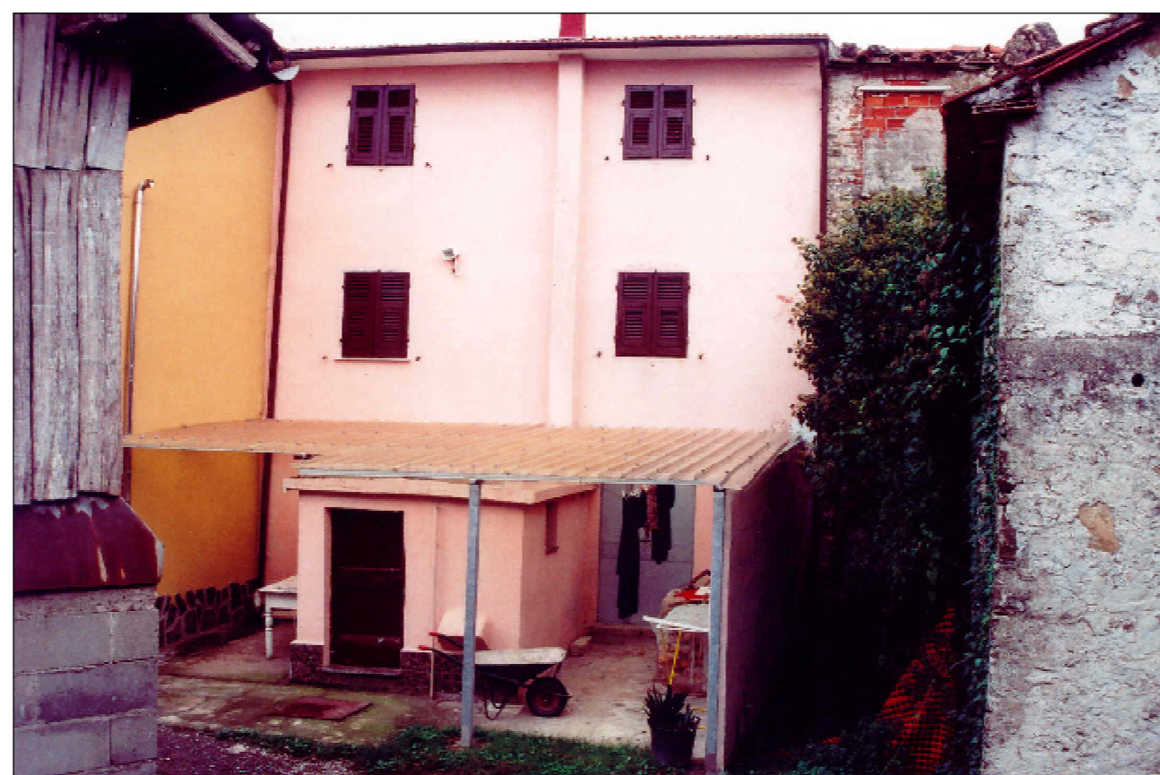
Vista n.6 Vista parziale da Ovest.
