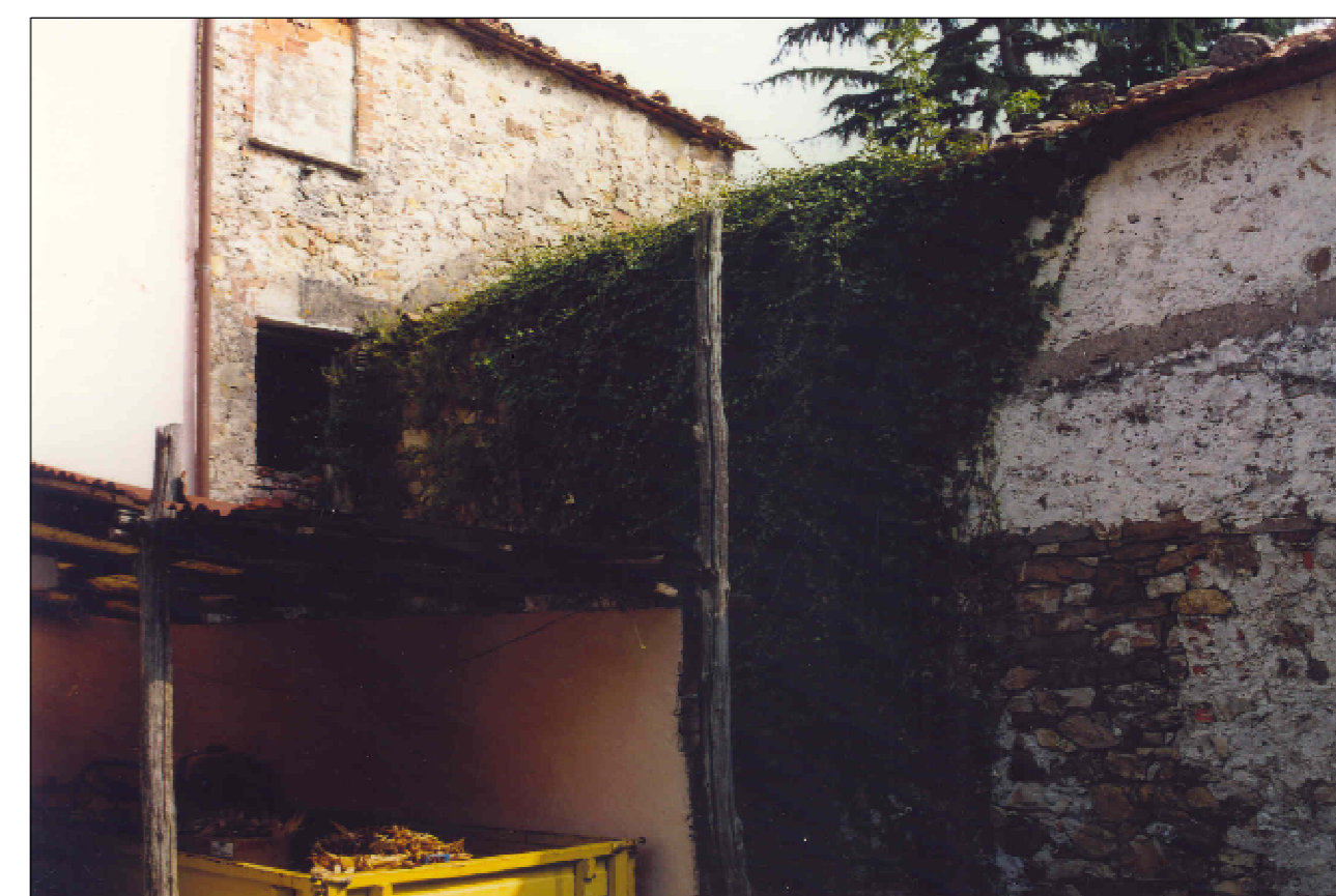
Vista n.7 Vista parziale da Ovest.
