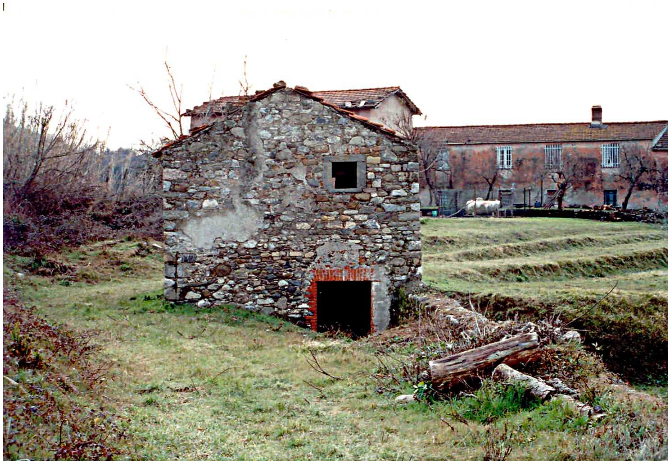
Vista da Nord-Ovest del fabbricato esistente
