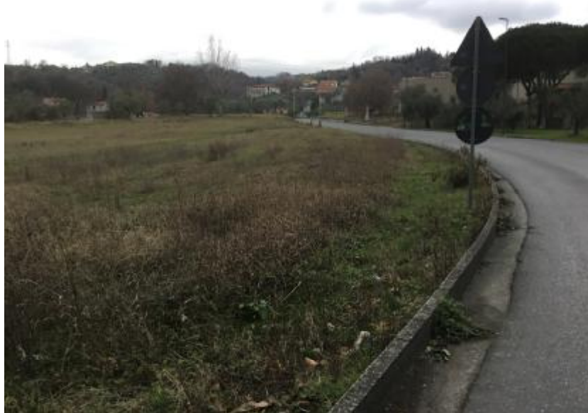
Foto n. 1 – Tratto iniziale in prossimità dell'Arco di Caniparola e del complesso scolastico
