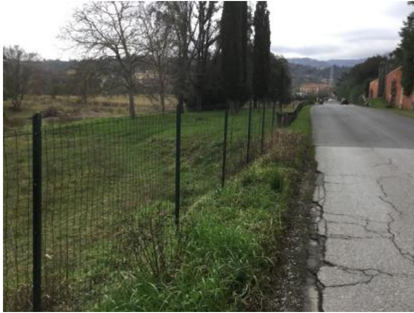
Foto n. 5 – Viale Malaspina Dettaglio della recinzione metallica oggetto di rimozione
