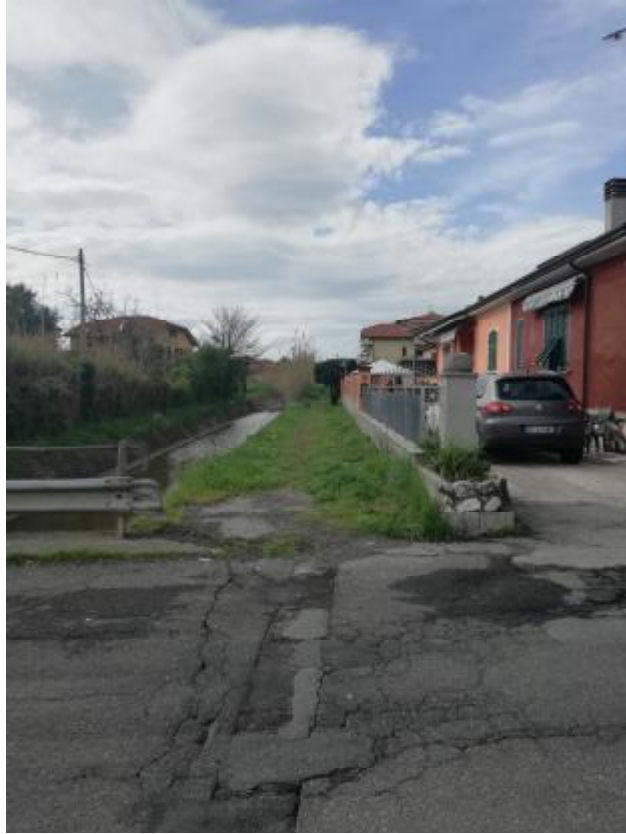
Foto n. 16 – Tratto lungo il Canale Lunense- Punto 4
