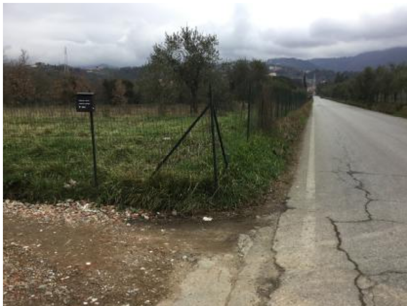
Foto n. 8 – Viale Malaspina Dettaglio del punto di innesto di viabilità privata sul Viale
