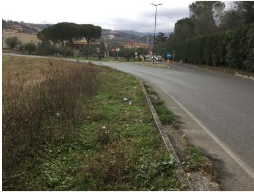
Foto n. 3 – Tratto iniziale in prossimità dell'Arco di Caniparola e del complesso scolastico
