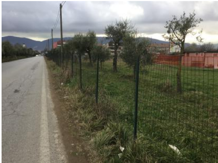
Foto n. 10 – Viale Malaspina Tratto in cui è previsto l'interramento della linea aerea ENEL
