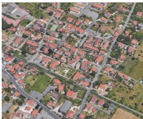
Fig. 2 - Particolare del tratto di percorso lungo il Canale Lunense
