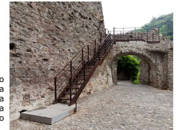
Esempio scala in acciaio corten e corrimano - Restauro del Castello del Doria a Dolceacqua - LD+SR architetti
