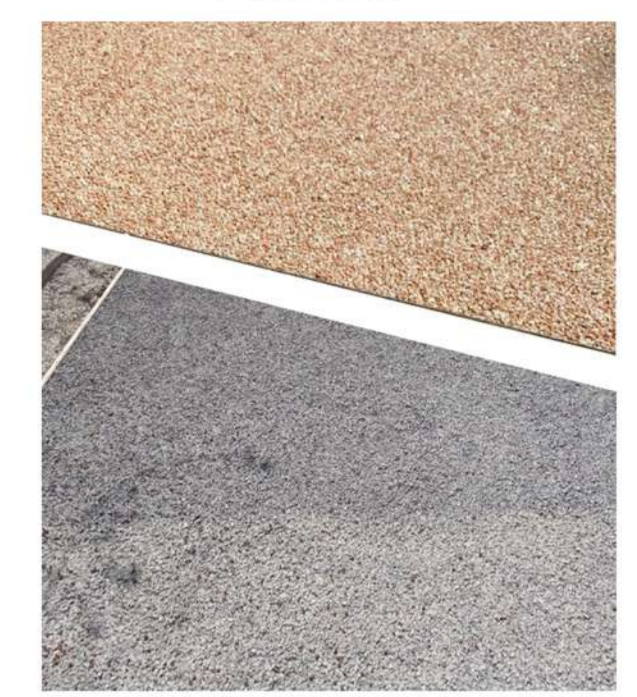
Esempio di pavimentazione in calcestruzzo drenante con diverse colorazioni.
