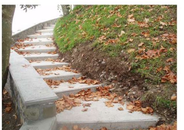
Esempio di scala in calcestruzzo armato
