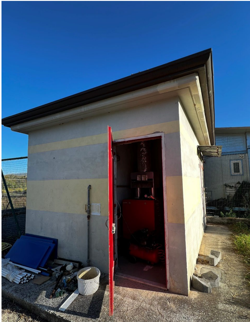
Attuale locale tecnico
