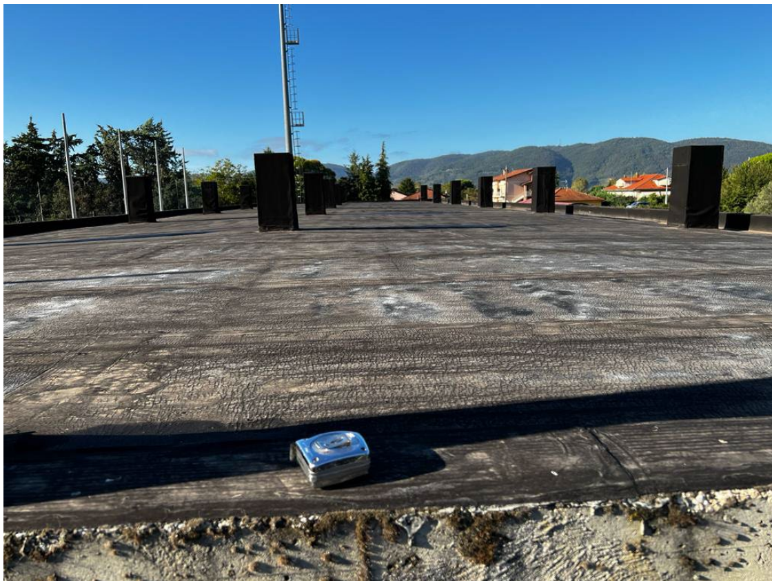
Impermeabilizzazione in copertura
